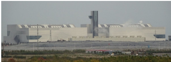
中国・上海市の廃棄物焼却施設(6000t/日) 400°C, 4MPa, 蒸気供給量約800t/hに相当
