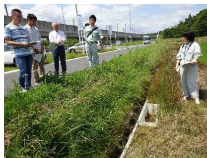
スロープ付き側溝の視察
